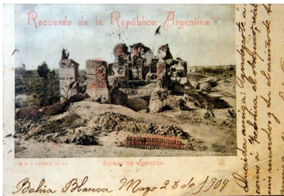
Antigua postal que muestra la destrucción de la Ciudad de Mendoza luego del terremoto.
